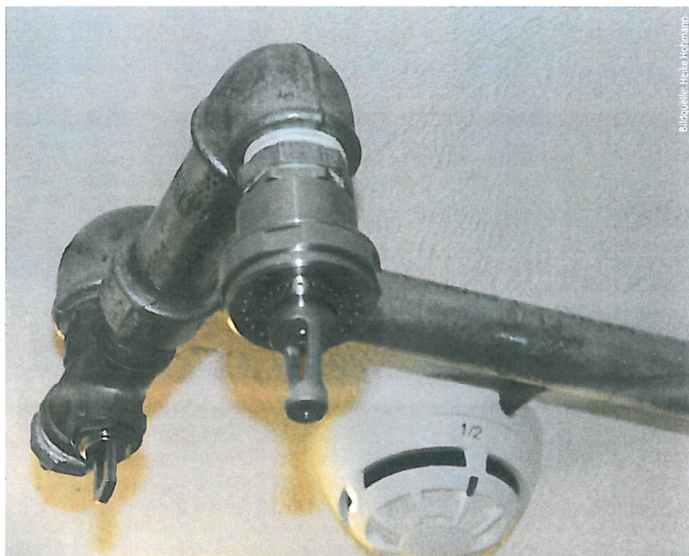
Abb. 1: Löschdüse und Auslöseventil mit thermischer Auslöseeinheit
