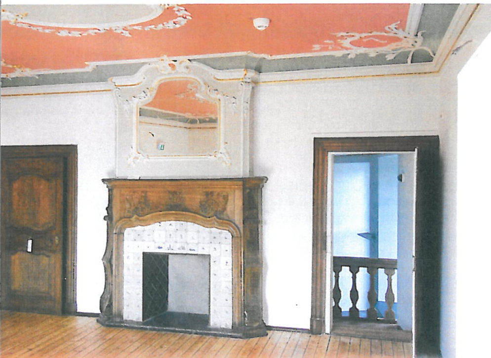
Das Schloss Moers ist ein Baudenkmal. Die sichtbaren Eingriffe in die Bausubstanz sollten beim Einbau der Löschanlage so gering als möglich gehalten werden.
